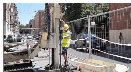
Fot. 6. Iniekcje bezpośrednie na jezdni w Obszarze 4
