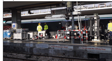
Fot. 5. Iniekcja PlumeStop na peronie dworca kolejowego w Obszarze 3
